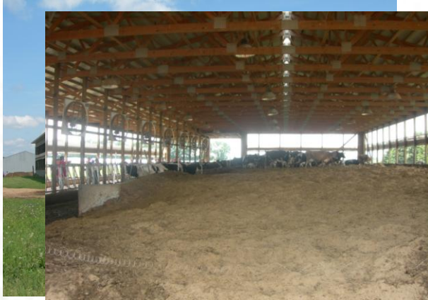
Uisolert hus melkeku, Minnesota, USA
